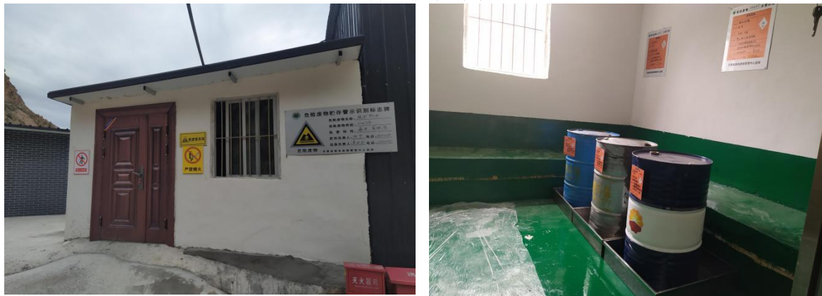
危险废物暂存间
