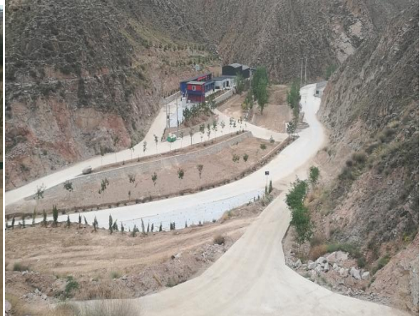
厂区道路硬化
