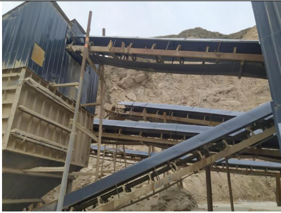
车间外封闭式廊道
