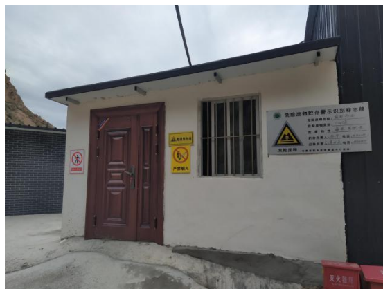
危险废物暂存间
